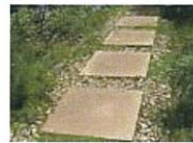
玄関へのアプローチの舗装材の例 : 砂岩
